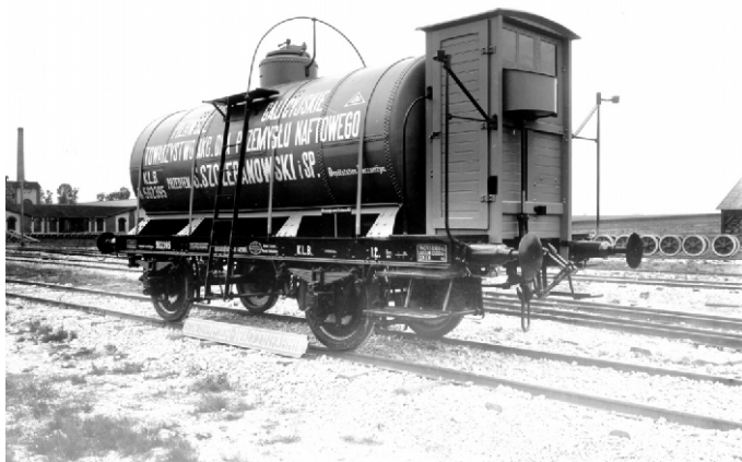
Dvounápravový kotlový vůz o obsahu 142 hl pro Halič, rok výroby 1901
