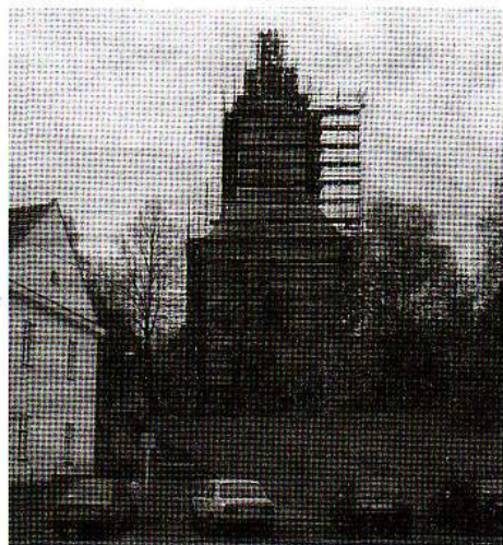
OPRAVA VĚŽE KOSTELA VŠECH SVATÝCH
