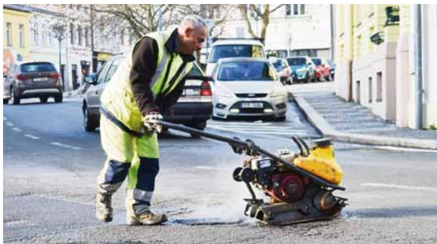
↑ PRACOVNÍK TECHNICKÝCH SLUŽEB OPRAVUJE JEDEN Z VÝTLUKŮ. FOTO: RENÉ STEJSKAL
