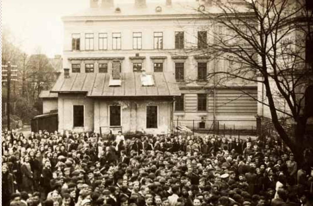
↑ NA FOTU Z ROKU 1928 JE ZA BEZRUČOVOU ŠKOLOU VIDĚT OBJEKT BÝVALÉ KOTELNY MĚSTSKÉ ELEKTRÁRNY, JIŽ S UBOURANÝM HLAVNÍM KOMÍNEM.
