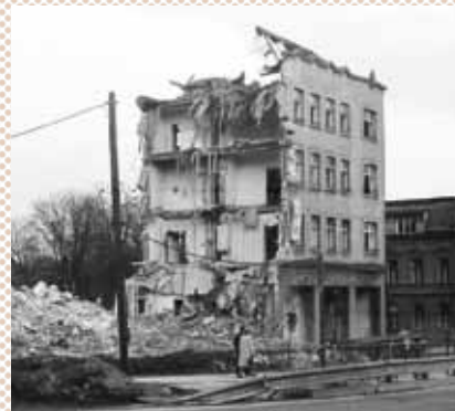
→ SMUTNÝ POHLED NA BOURÁNÍ OBCHODNÍHO DOMU J. HÜCKELA.
