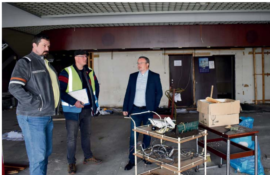
↑ NÁMĚSTEK PRIMÁTORA RADOVAN HOŘÍNEK (VLEVO) S JIŘÍM ČUDOU (ZCELA VPRAVO) A STAVBYVEDOUČÍM DISTEPU V PROSTORÁCH HOTELU V MÍSTĚ, KDE BUDE SÍDLIT DOPRAVA, ÚDRŽBA A VEDENÍ FIRMY. FOTO: RENÉ STEJSKAL
