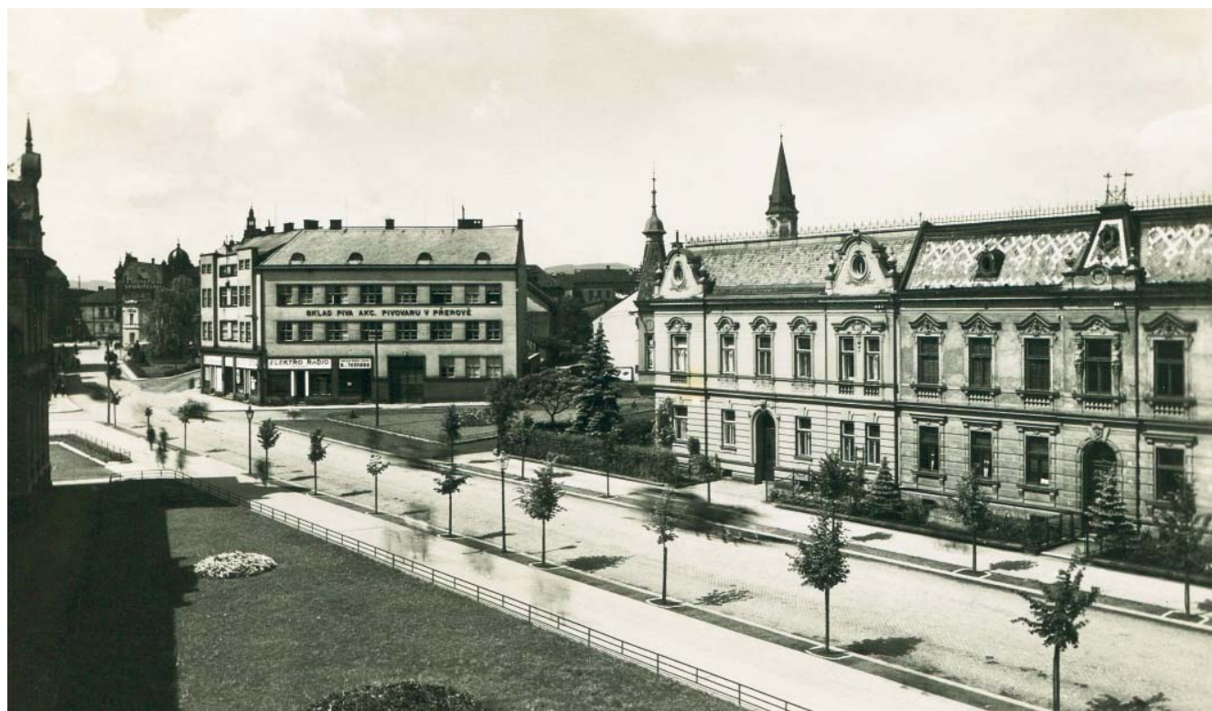
POKLIDNÁ ATMOSFÉRA V MÍSTKU JEŠTĚ PŘED VÝSTAVBOU PRŮTAHU.
