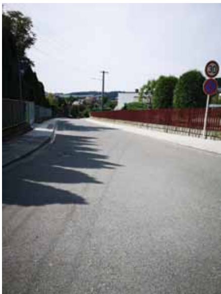
Opravený chodník, ulice Na Strážnici
