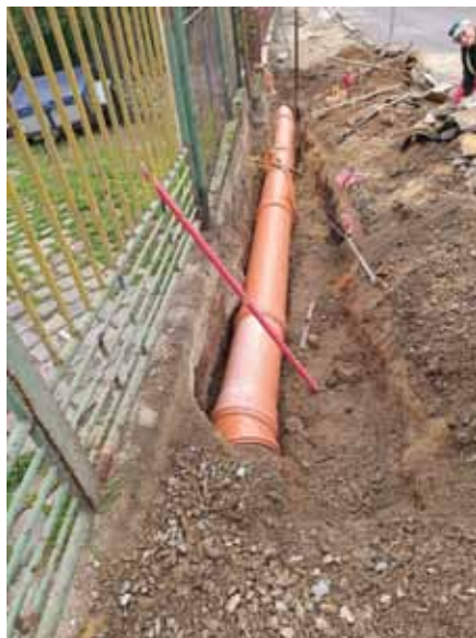
Oprava kanalizace, ulice Na Strážnici
