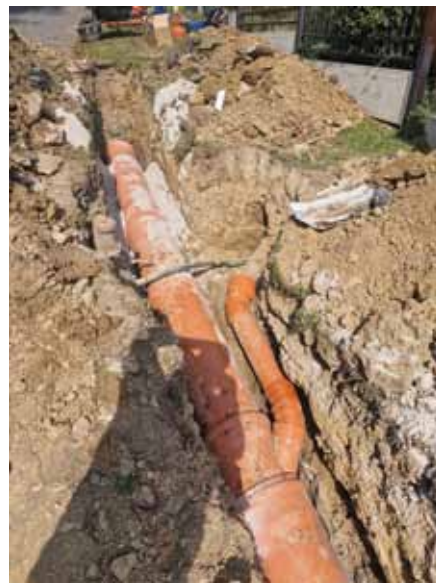
Oprava kanalizace, ulice K Oboře
