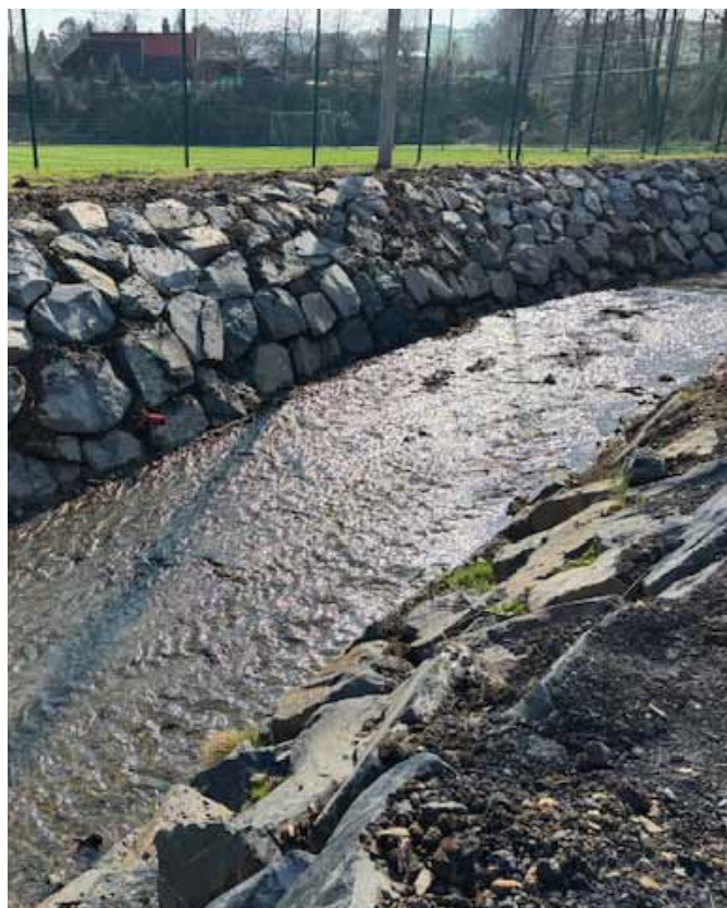
Dokončení I. etapy oprav ul. Potoční
