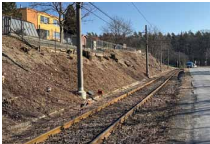
Prořezávka křižovatky Kyjovská / Čs. tankisů za účelem zvýšení rozhledových úhlů
