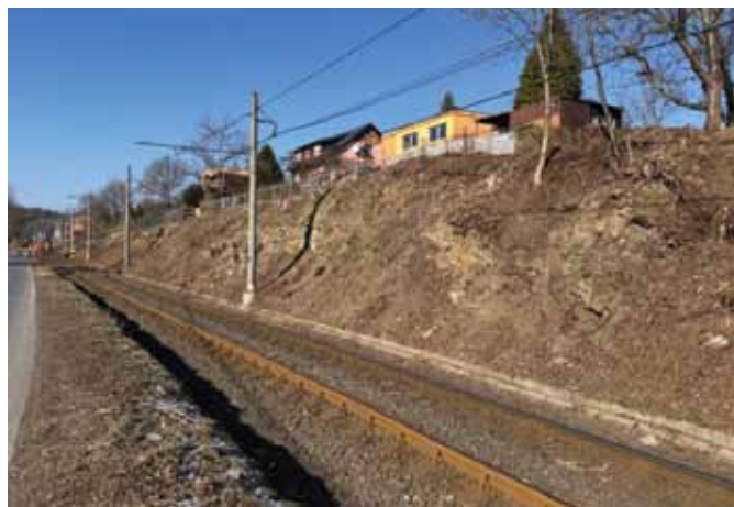
Prořezávka křižovatky Kyjovská / Čs. tankisů za účelem zvýšení rozhledových úhlů
