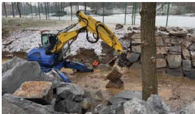
Průběh oprav a ukládání kamenů
