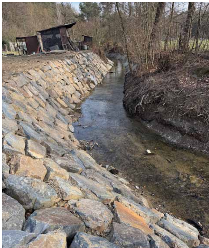
Finální pohled na opravený břeh
