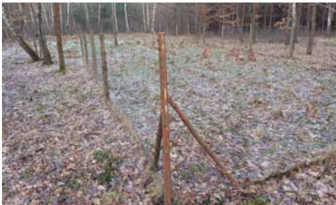
Oprava stávajících oplocenek
