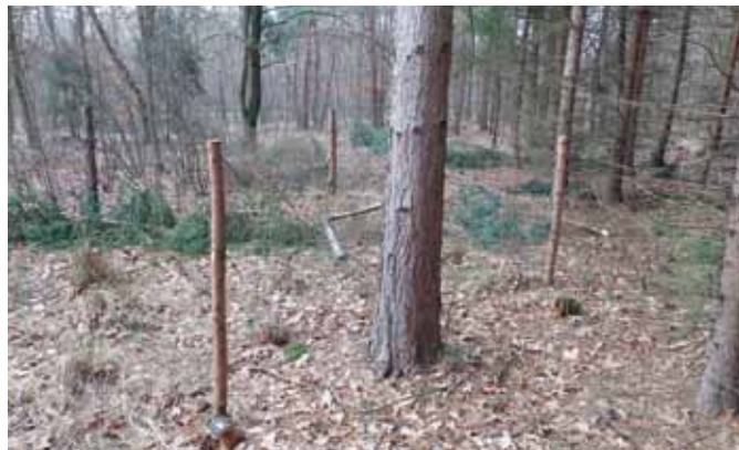
Oprava stávajících oplocenek
