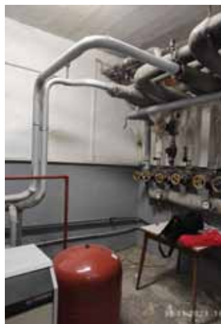
Rozdělovač, sběrač s topnými okruhy
