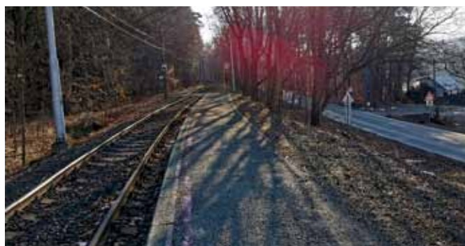
Průběh prací Stav zastávky a koridoru trati po vyčištění
