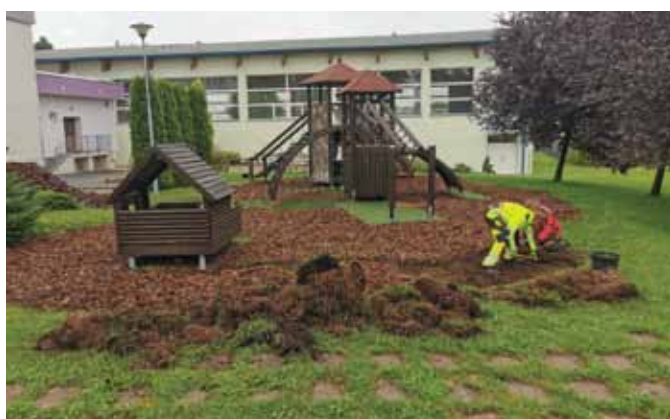
Průběh prací – odstranění trsů trávy
