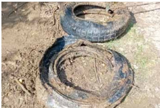
Vnitřní pohled na ucpaný propustek, který způsobily dvě pneumatiky a dřeviny
