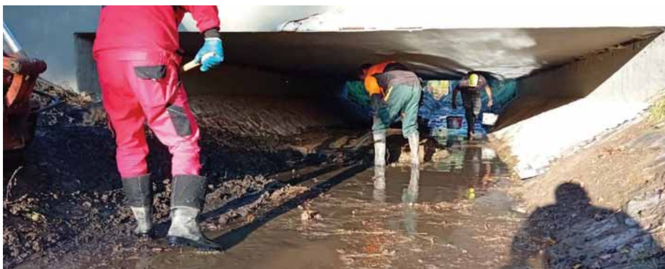
Ruční čištění mostního propustku
