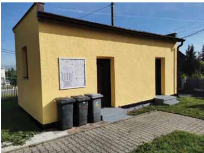
Současný stav po nátěru fasády a okapů
