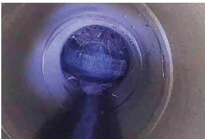
Vnitřní pohled na ucpaný propustek, který způsobily dvě pneumatiky a dřeviny
