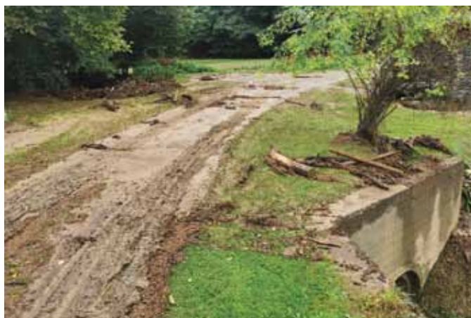
Stav po záplavách, kdy voda protékala po cestě přes ucpaný propustek
