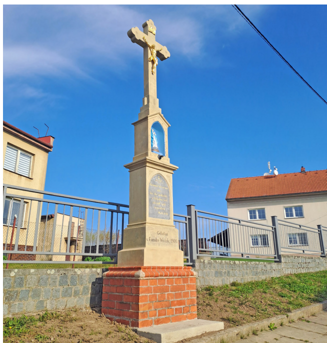
Opravený kříž na Slezské ulici
