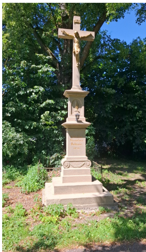
Stav po obnově
