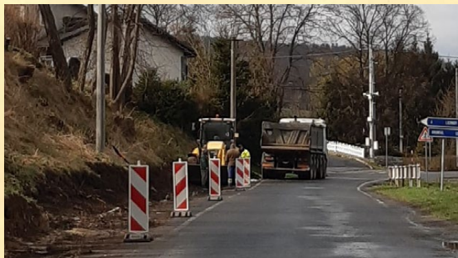
Začínáme stavět chodník na brantické ulici.
