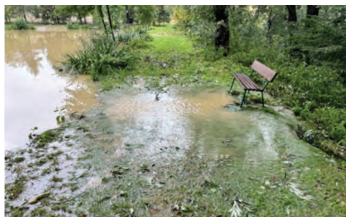
Přetékající hráz rybníka v Oši a počínající nátrž na vzdušné straně hráze během povodně (v levém horním rohu je vidět vtok erozního splachu z polí) Foto poskytl: HZS Vřesina
