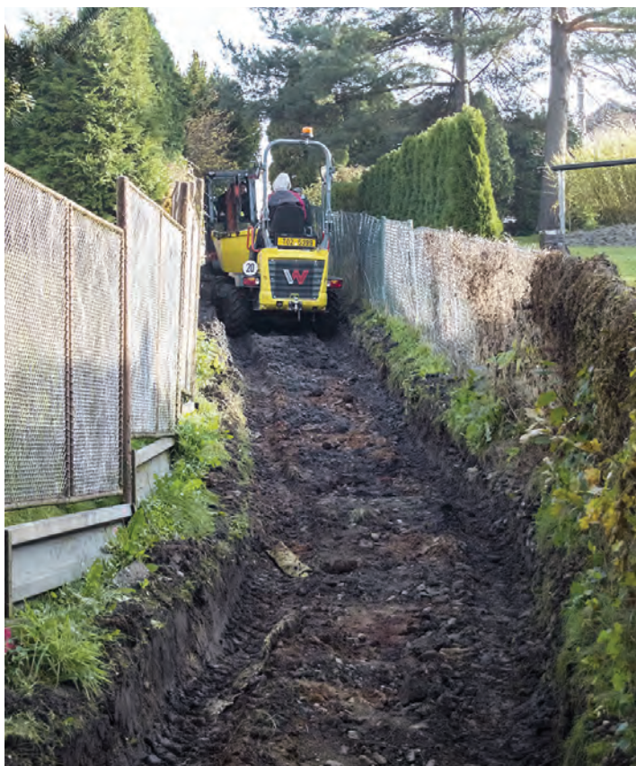
Oprava chodníku Na Potůčku
