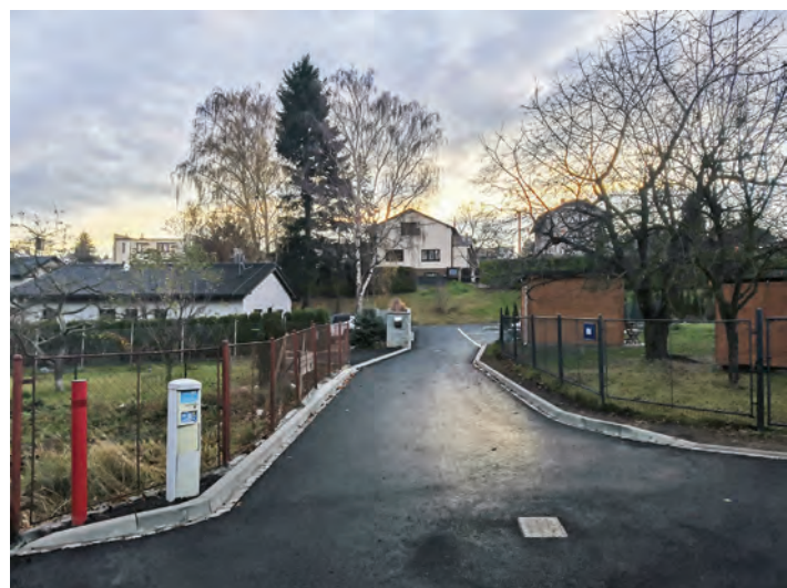
Opravy komunikace ul. Důlní, chodníku ul. Hlavní a výstavba kolumbária
