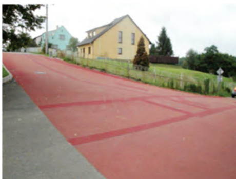
reklamační oprava povrchu na ulicích Pod Lípou a Nad Opustou
