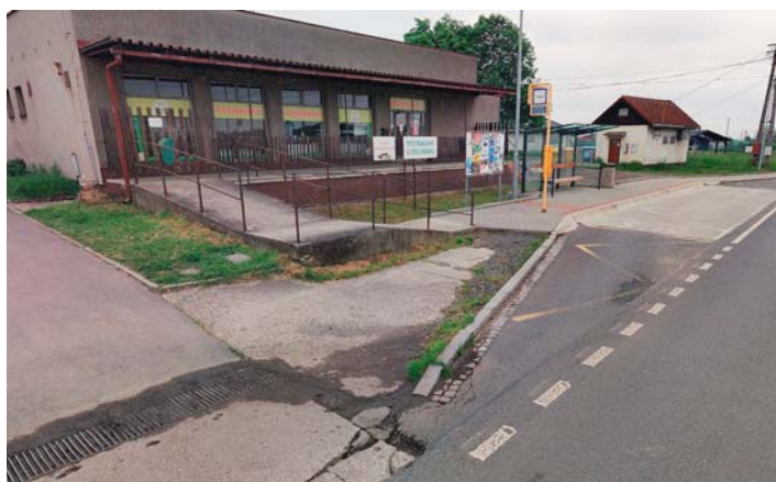
Prostor u zastávky Koliba před rekonstrukcí.
