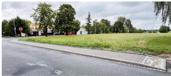
Chodník Na Příčnici po opravě.
