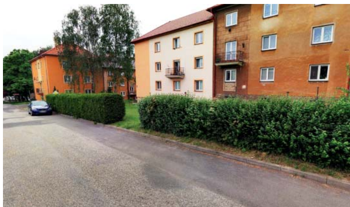
Na Vyhlídce - před rekonstrukcí.
