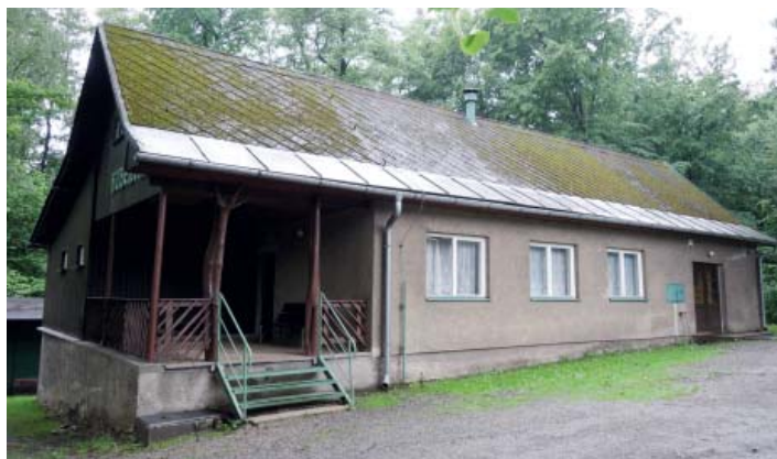
Myslivecká chata Hubertka před a po rekonstrukci střechy.
