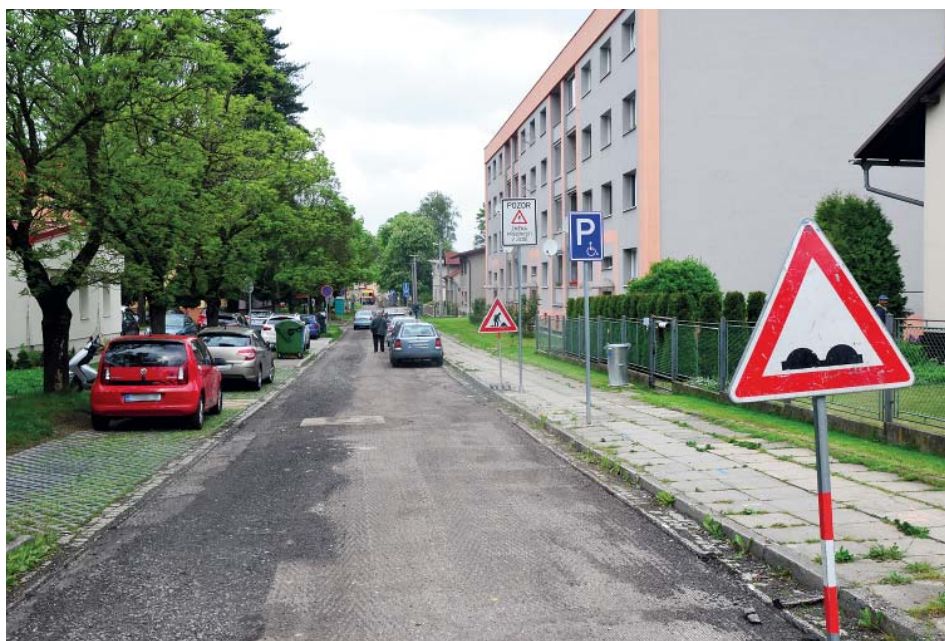
Jedním z míst, kde se pracuje na rekonstrukci plynovodu, je ulice Sokolská.
