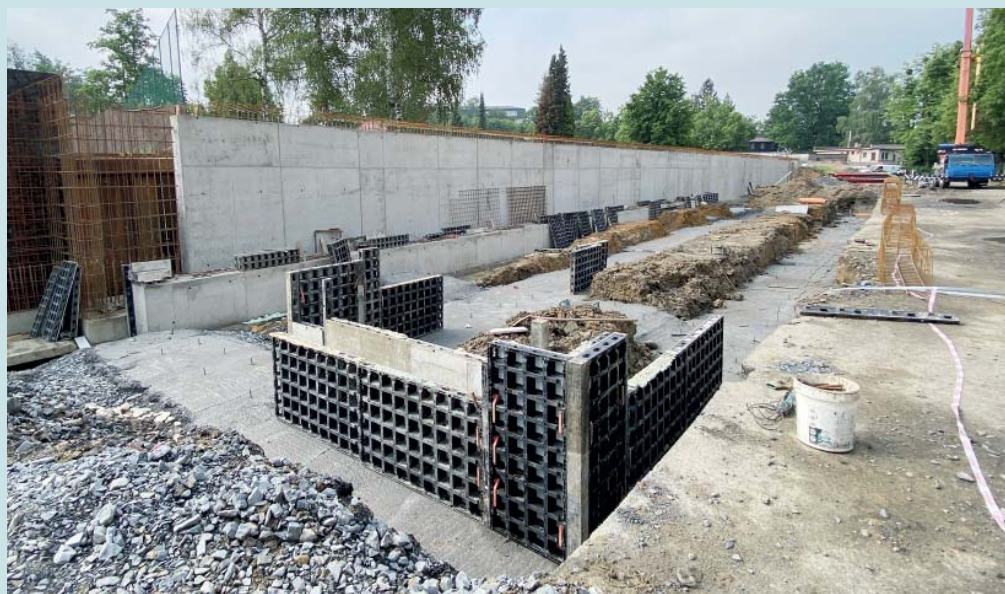
Na snímku je vidět dokončená opěrná stěna a práce na základové konstrukci nové budovy. Foto: MěÚ
