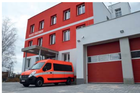
Jednou z nejdůležitějších investic loňského roku byla rekonstrukce hasičské zbrojnice.
