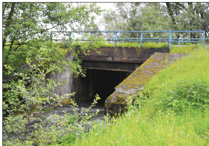
most J. Tomise před opravou, foto (ak)
