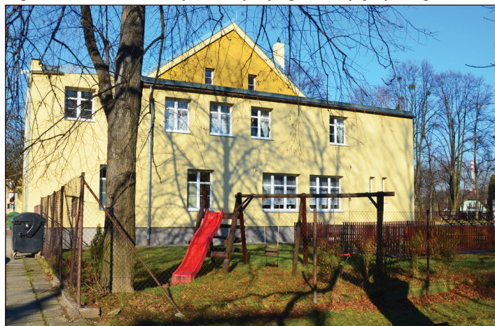
Sokolovna ve Vratimově po rekonstrukci, foto (ak)
