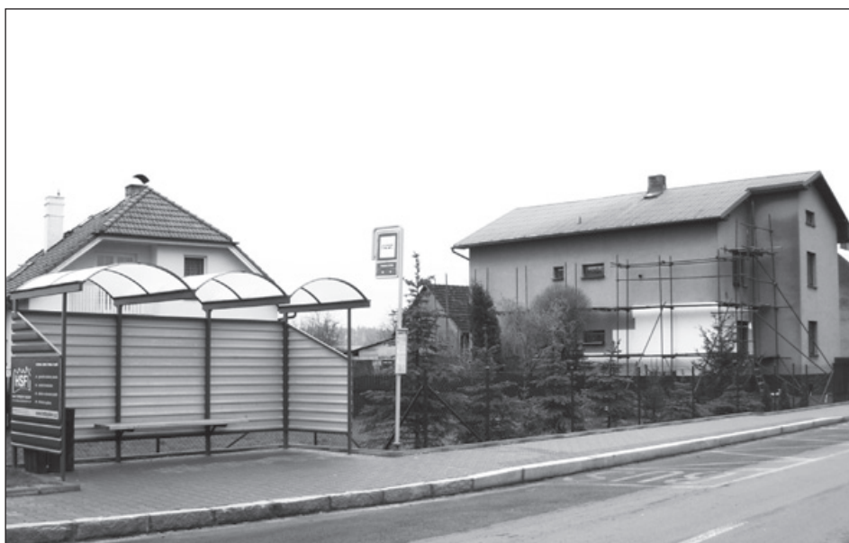
Nový chodník a zastávka na křižovatce ul. Frýdecká a Adámková
