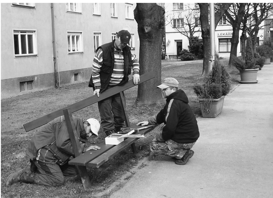
Zaměstnanci Vratimovských služeb při opravě poškozených laviček
