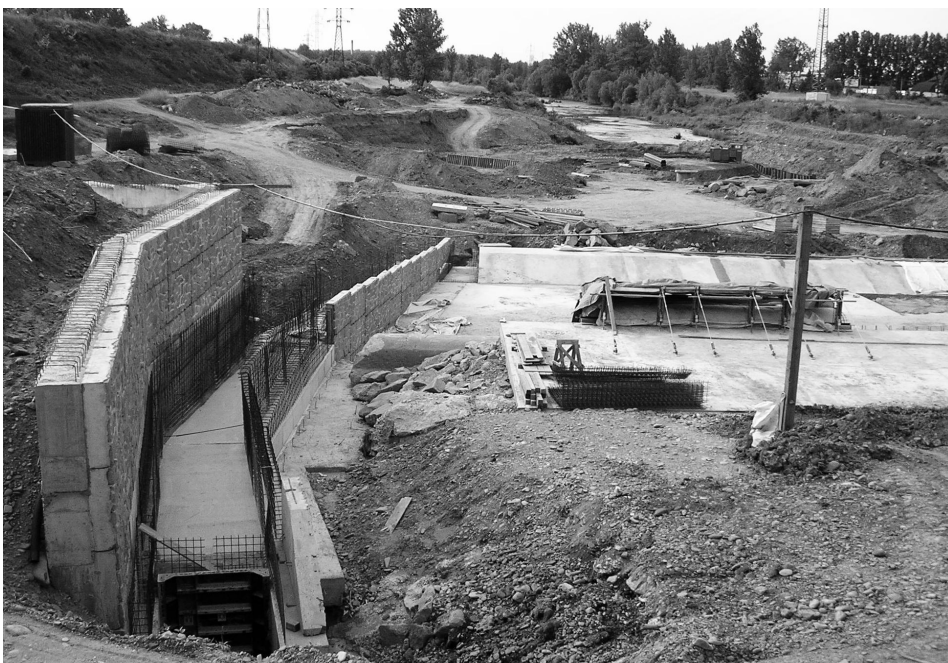
Pohled na řečiště při rekonstrukci jezu
