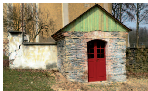
Po ukončení I. etapy obnovy.
