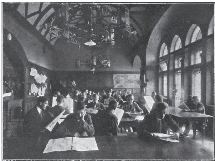
Vnitřek městské veřejné čítárny v M. Ostravě-Vítkovicích. Innenansicht der öffentl. städt. Lesehalle Mähr. Ostrau-Vítkovice.
