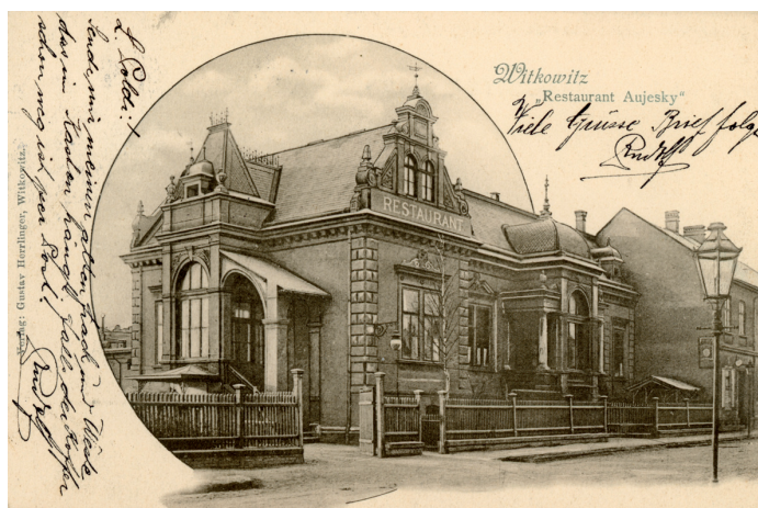
Mihatschova vila č. p. 333 s restaurací Františka Aujeského, počátek 20. století.
