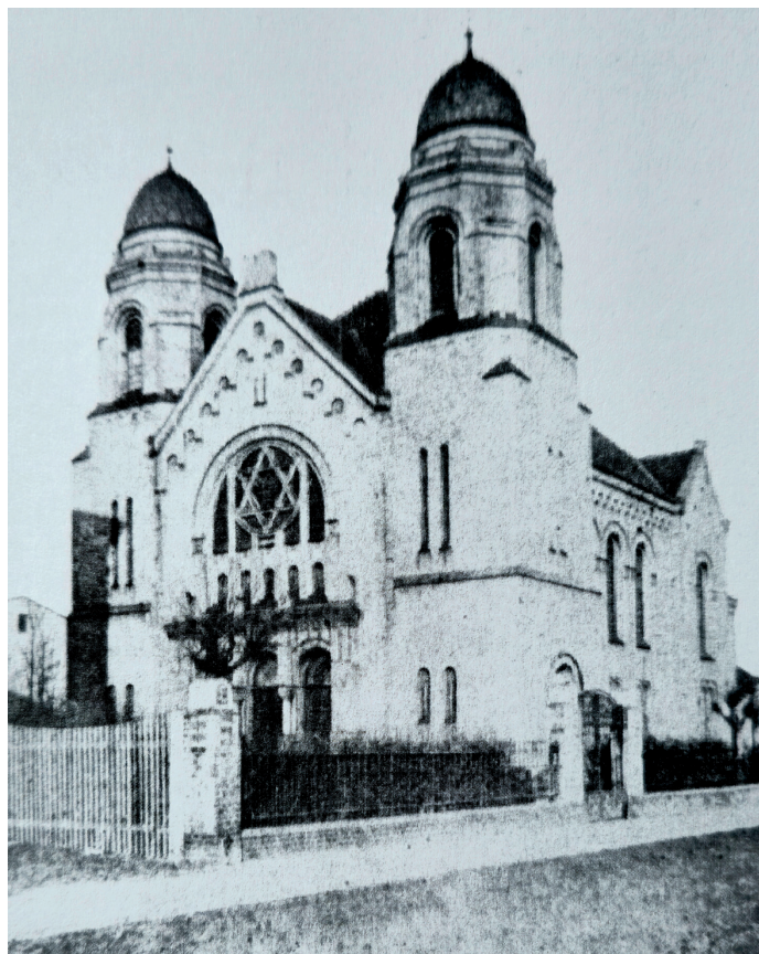
Průčelí templu ve Vítkovících, desátá léta 20. století.
