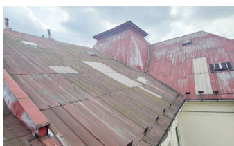
Stav před opravou.
