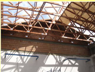
Více než 13 milionů korun si vyžádala rekonstrukce tělocvičny v r. 2008
