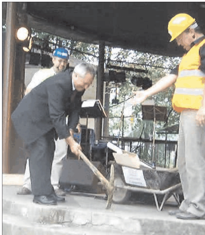
Symbolické zahájení stavby kanalizace na letošním Karnevalu...
