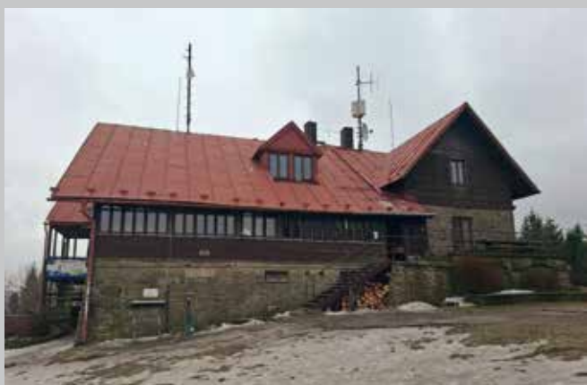
Turistická chata Javorový – rekonstrukce střechy
