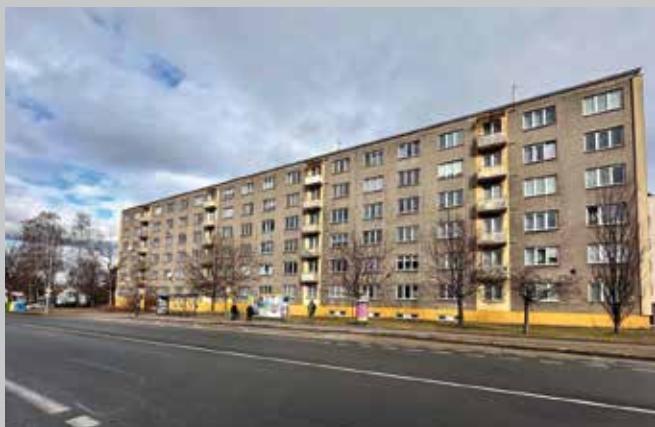
Bytový dům, Třinec, ul. Lidická 549-552 – rekonstrukce střechy
