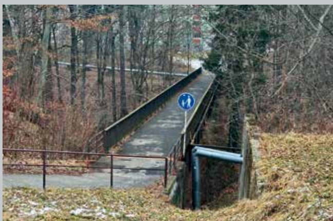
Energolávka k nemocnici – oprava
