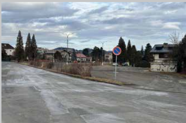
Ulice Tyršova, Třinec – rekonstrukce ulice, včetně parkoviště
