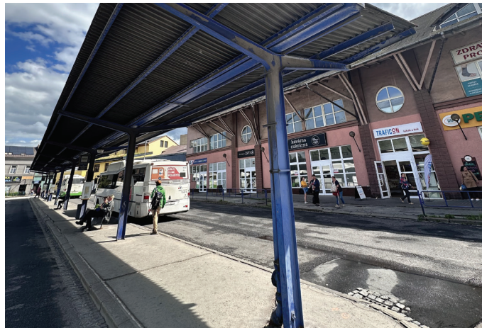
2) Rekonstrukce autobusového stanoviště – předpokládaná cena 35 milionů korun
