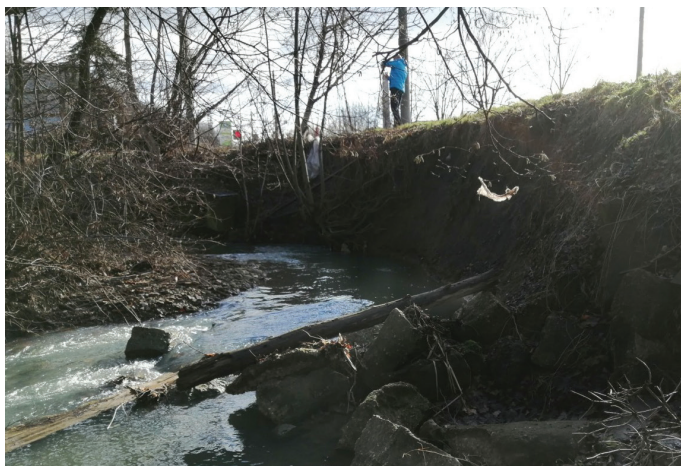
7) Zajištění břehového svahu toku Staviska – předpokládaná cena 5,5 milionu korun
