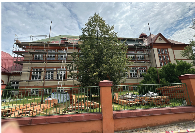
11) Rekonstrukce střechy ZŠ Bezruče – předpokládaná cena 9 milionů korun
