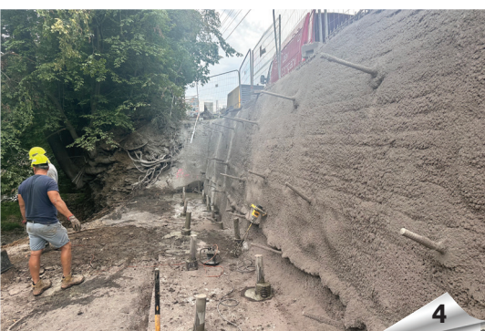
4) Zajištění svahových břehů Olše nad komunikací
