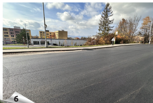
6) Ul. Kaštanová – rekonstrukce
