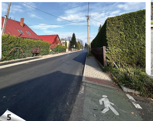
5) Silnice Nebory-Podlesí k "Válcovně C" – rekonstrukce povrchu komunikace, lokální oprava chodníků, vpusti
