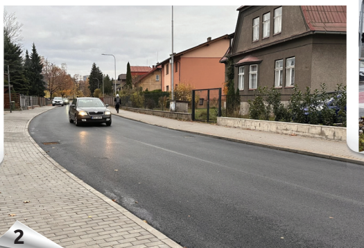
2) Ulice Husova – oprava povrchu, úprava chodníku, vpusti
