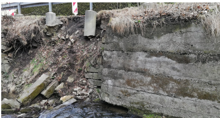
Původní stav břehového svahu Líštnice (u čp. 26 a 27)
