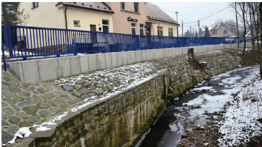
Pohled na zajištěný svah vodního toku Líštnice
