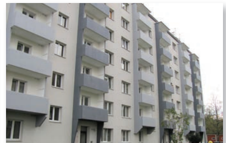
2. místo – obnova fasády, zateplení a montáž lodžii bytového domu Máchova 634. Investorem je Společenství vlastníků jednotek domu č. 634-636, autorem návrhu je Ing. Zelinka, s. r. o.
