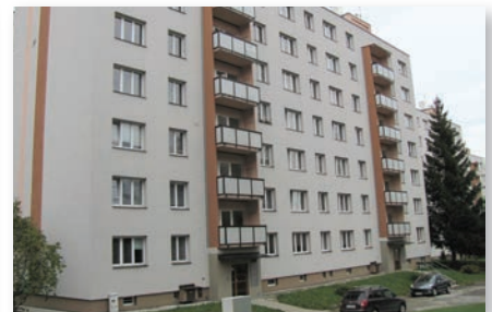
2. místo – obnova fasády a zateplení bytového domu Beskydská 721. Investorem je Společenství vlastníků jednotek domu č. 721-726, autorem návrhu je Ing. Zelinka, s. r. o.
