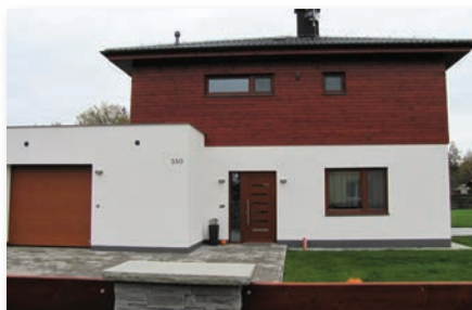
2. místo – stavba rodinného domu v Neborech. Stavebníky jsou Petra a Roman Kubiszovi.
