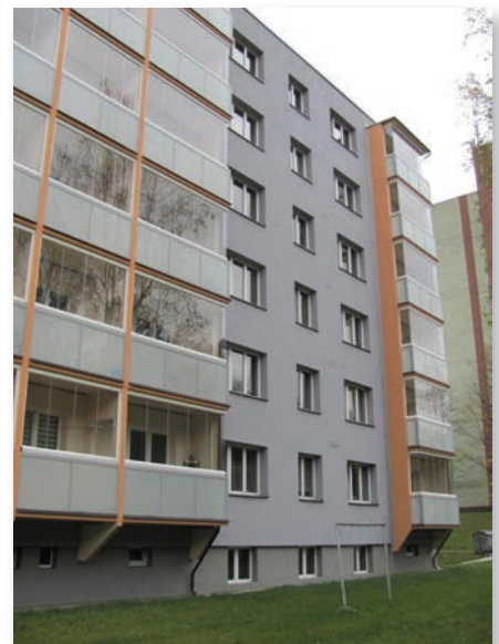
1. místo – obnova fasády a zateplení bytového domu Beskydská 727. Investorem je Společenství vlastníků jednotek domu č. 727-731, autorem návrhu je Ing. Zelinka, s. r. o.
