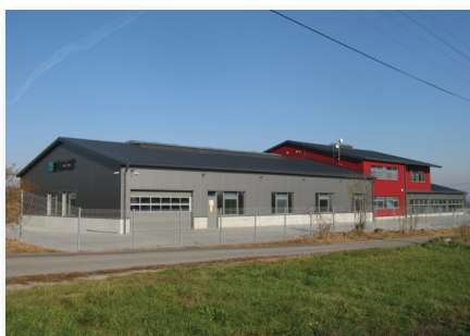
1. místo – hala a administrativní objekt firmy MEPAC CZ, s. r. o., v Neborech. Investorem je firma MEPAC CZ, s. r. o., autorem návrhu je Ing. arch. Alena Vojtechovská, TimedArch DESIGN, s. r. o.
