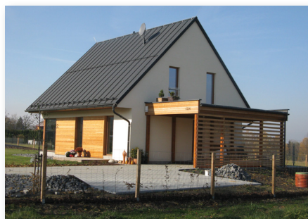
1. místo – stavba rodinného domu v Lyžbicích. Stavebníkem je L & T Real, spol. s r. o., autorem návrhu je Ing. Pavel Sousedík.
