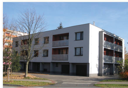
1. místo – revitalizace bytového domu v Lyžbicích, ul. Lidická. Investorem je Společenství vlastníků jednotek domu 793, autorem návrhu je Projekční ateliér – Ing. Zelinka, s. r. o.
