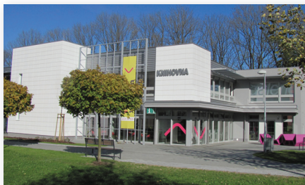
1. místo – rekonstrukce knihovny Třinec. Investorem je město Třinec. Autorem návrhu je Ing. arch. Blanka Petrovová, Ateliér Frýdek.
