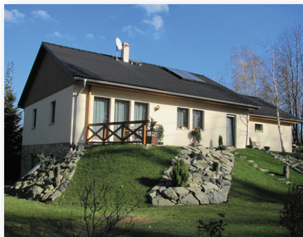
2. místo – stavba rodinného domu v Oldřichovicích. Stavebníkem je Marek Klečacký. Autorem návrhu je Ing. František Klečacký.
