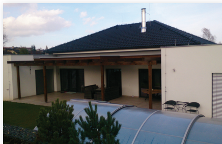
1. místo – stavba rodinného domu v Lyžbících. Stavebníkem je Petr Šiška. Autorem návrhu je ALTABIX, s. r. o.
