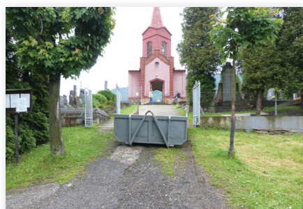
hřbitova o používání vedlejšího vchodu. Vedlejší vchod bude používán rovněž i pro pohřby, které budou v tomto období probíhat. Stavba by měla být ukončena 31. srpna 2014. (šs)
