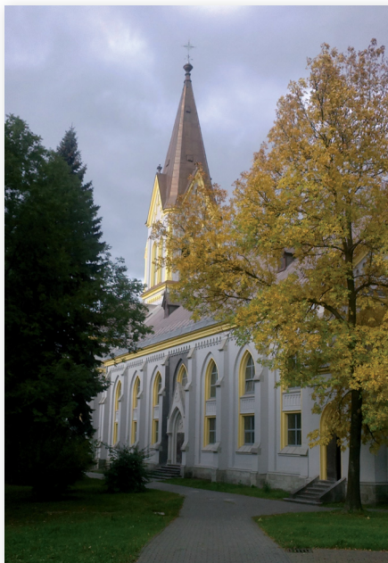
Třinec, které přispělo částkou 700 tisíc korun na opravu konstrukce krovu a střešní krytiny věže. (Šš)
