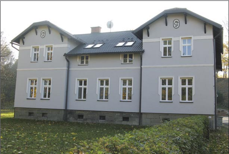
Vítěz kategorie Obnova fasád stávajících objektů
