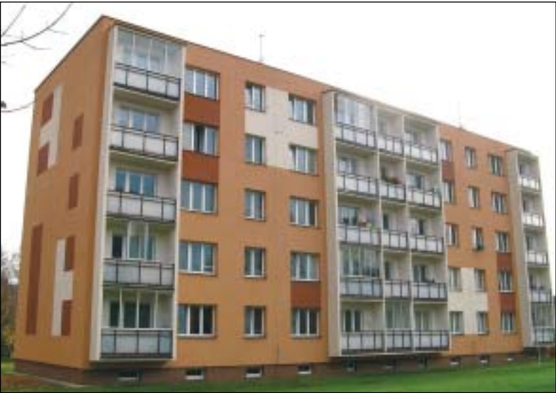
Vítězná „obnovená fasáda“.
