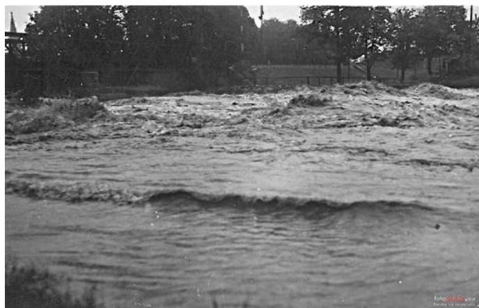
Záběr na železniční most směrem na Cieszyn.
