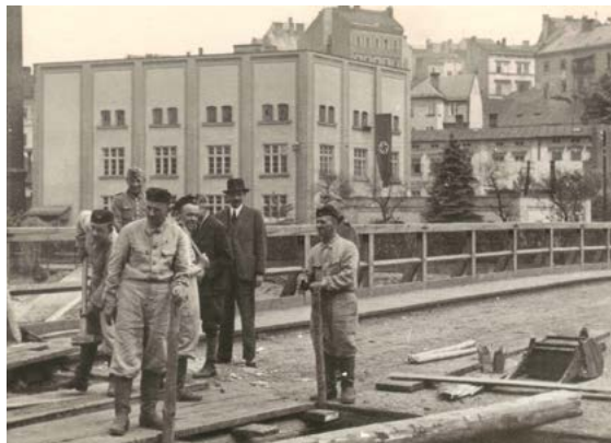
Výstavba Válečného mostu v roce 1939. Foto | soukromá sbírka Czesława Krainy
