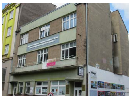
Budova PZKO - před opravou – srpen 2022
