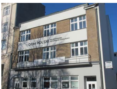
Budova PZKO - po opravě – leden 2026
