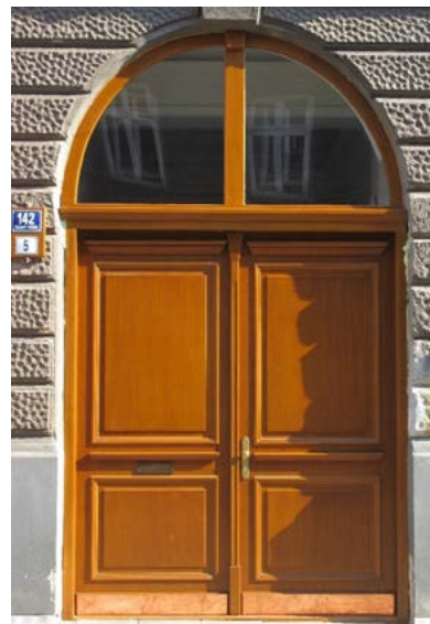
Božkova 142/5 – vstupní vrata po výměně
