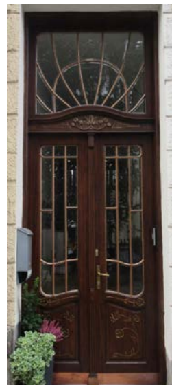
Vrchlického 110/7 – vstupní dveře po obnově
