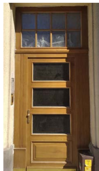
Nám. ČSA 181/8 – vstupní dveře po výměně
