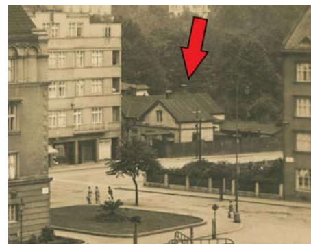
Pohled z radničního náměstí do Smetanovy ulice. Šipka míří na hospodářskou budovu. Kolem roku 1935.
