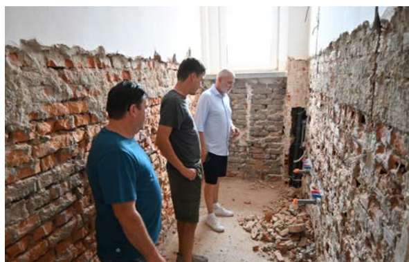
Rekonstrukce toalet Polské základní a mateřské školy
