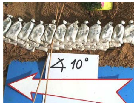
Pytle se vždy ukládají mírně šikmo po směru proudění vody, patou pytle k vodě!
