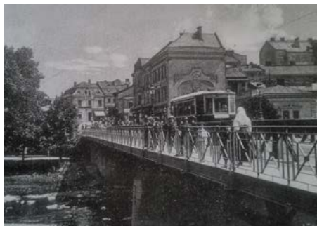
Tramvaj na Hlavním(most Družby) mostě rok 1915
